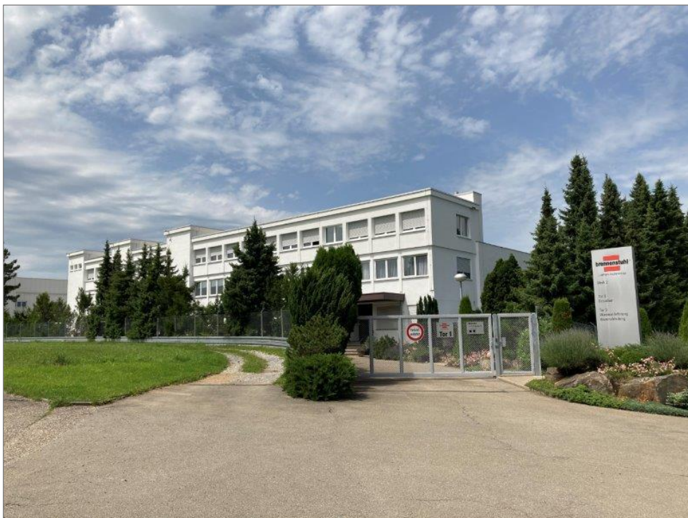
Abb. 8: Gewerbliche Flächen im Nordosten des Plangebiets (Foto: HPC AG, 12.07.2021)
