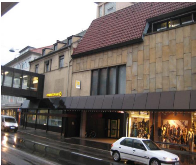
Bild 3: Bestand Abbruch Friedrichstraße 4
