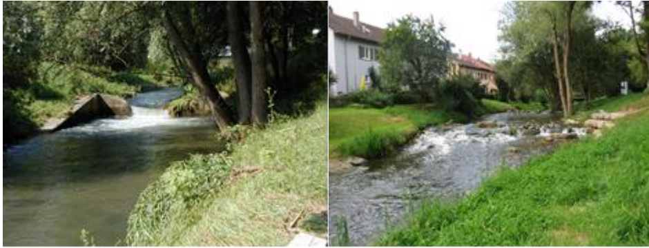
Ammer, Absturz an der Aischbachschule
