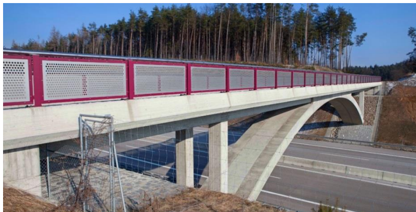
Ansicht Stahlbetonbogenbrücke IB bulicek, München
