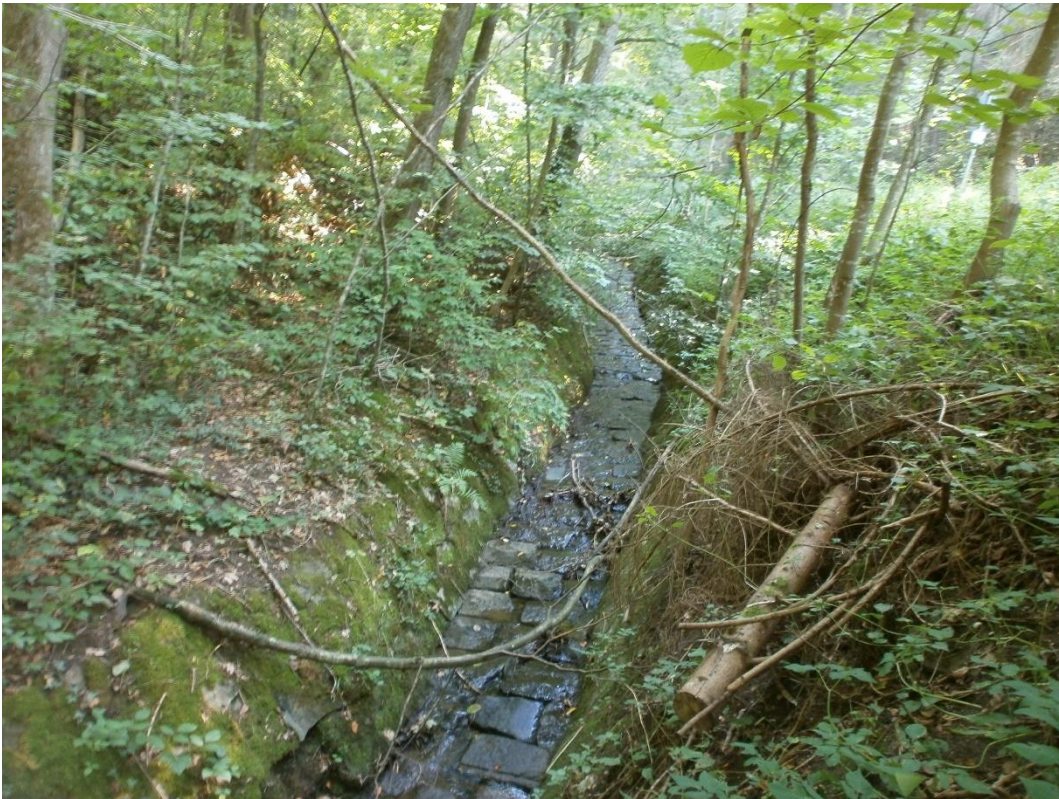
Abb. 12: Derzeitiger ausgebauter Abschnitt am Käsenbach
