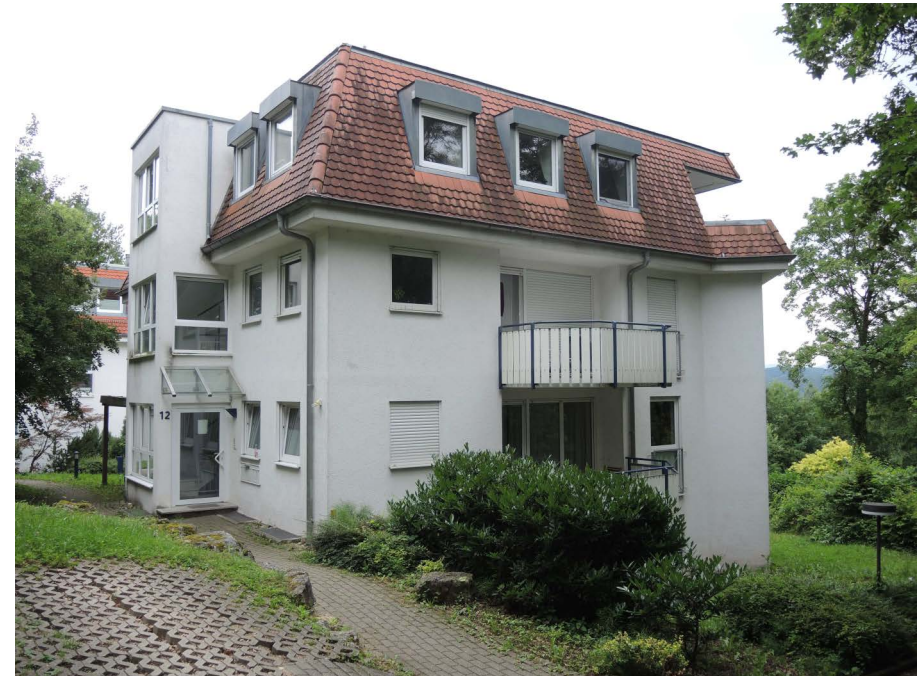
Ansicht des Wohngebäudes von Westen
