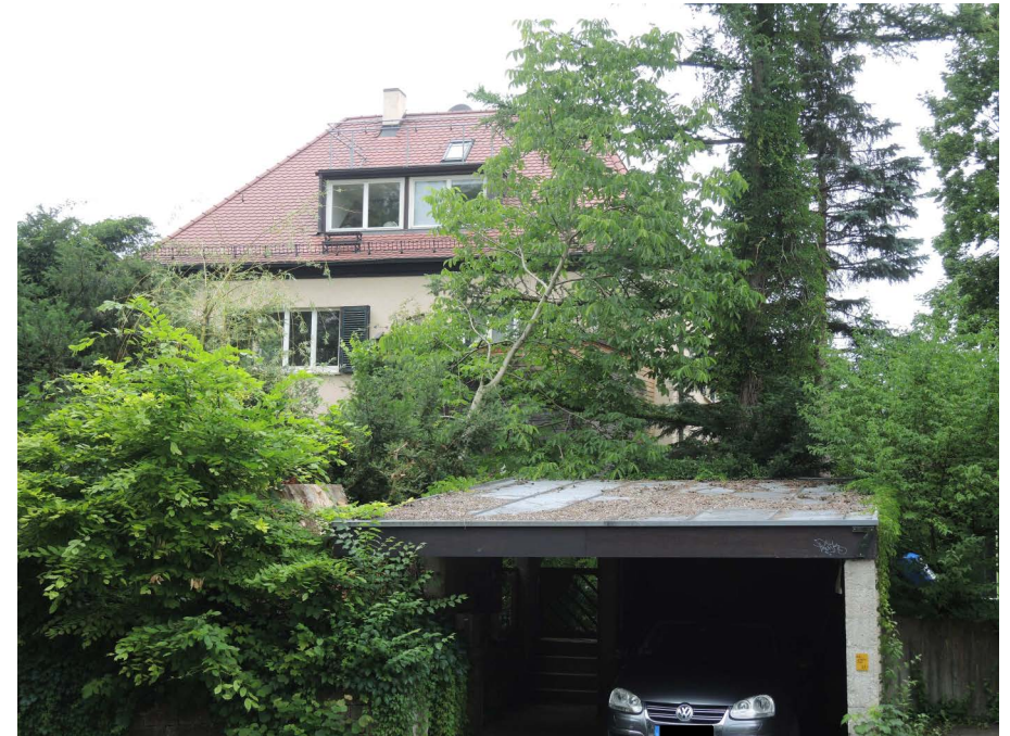
Ansicht des Wohngebäudes von Südosten
