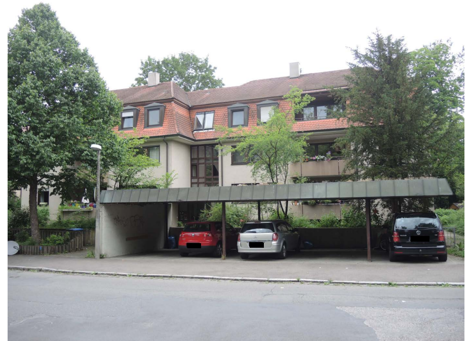
Ansicht des Wohngebäudes von Südosten
