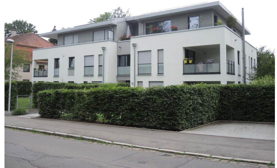
Ansicht des Wohngebäudes von Südosten
