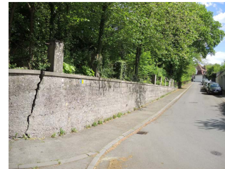
Ansicht der Garteneinfriedung an der Straße
