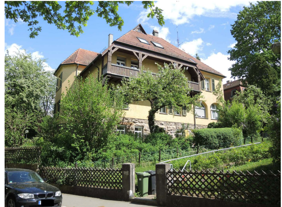
Ansicht des Wohngebäudes von Westen
