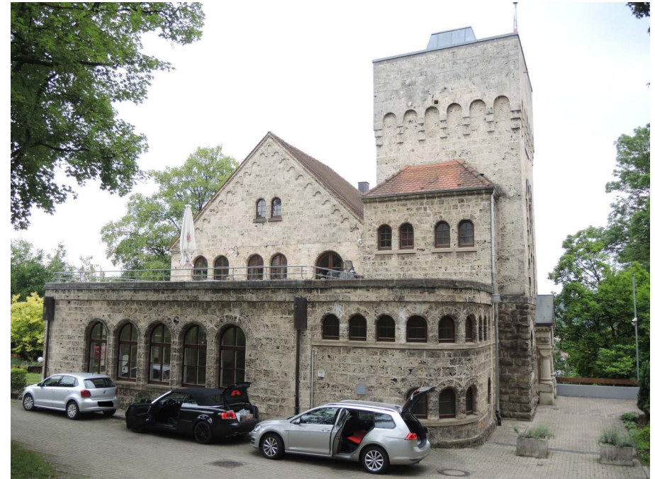
Ansicht des Verbindungshauses von Nordwesten
