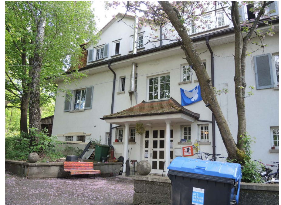
Ansicht des Gebäudes von Nordwesten
