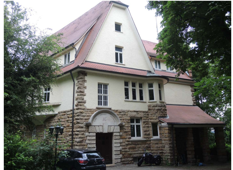
Ansicht des Verbindungshauses von Nordwesten
