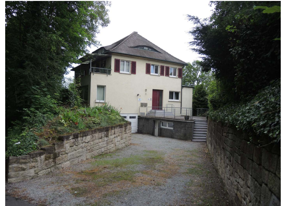
Ansicht des Gebäudes von Südosten
