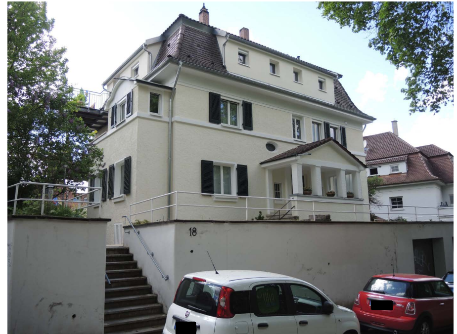
Ansicht des Gebäudes von Osten
