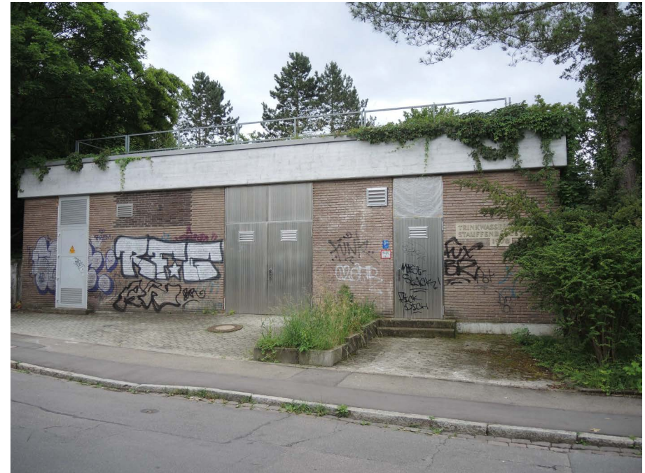
Ansicht des Wasserbehälters von Nordwesten
