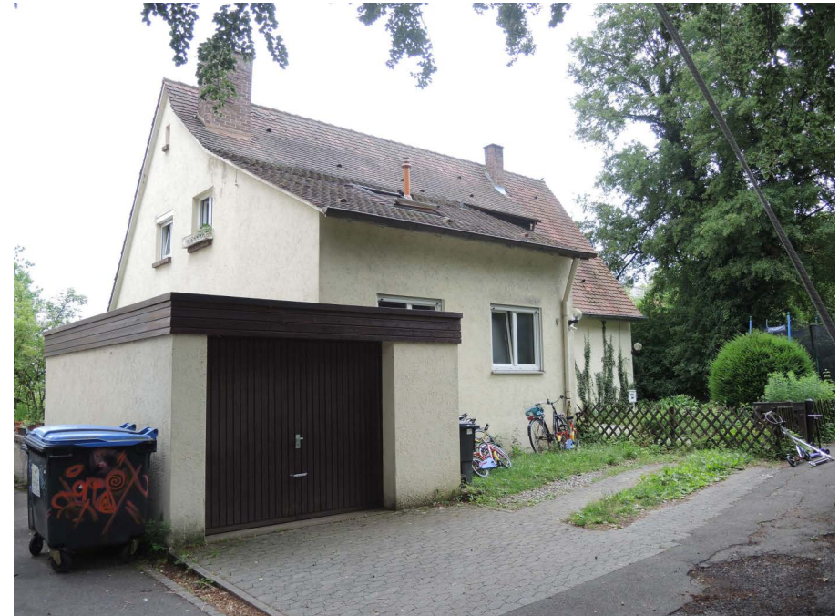
Ansicht des Wohnhauses von Nordosten
