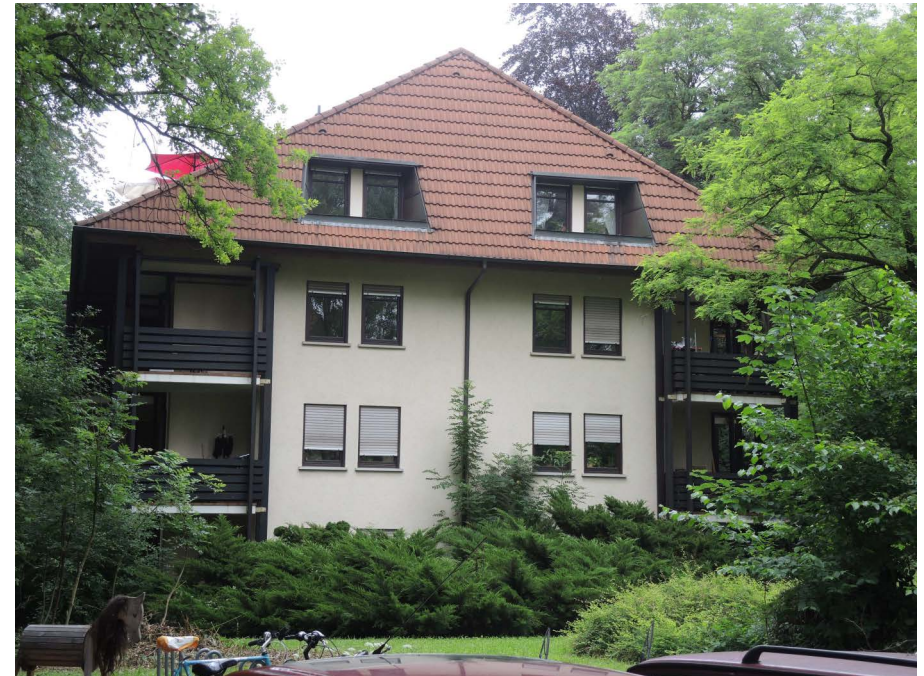
Ansicht des Wohngebäudes von Süden
