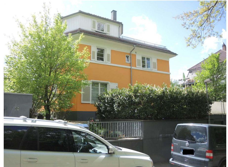
Ansicht des Gebäudes von Osten
