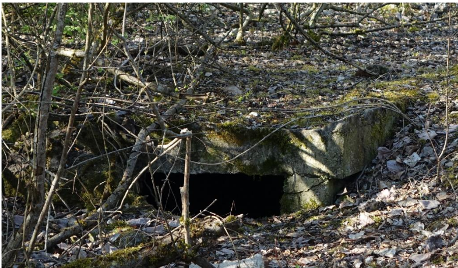
Abb. 5: Kelleröffnung im Untersuchungsgebiet
