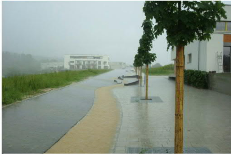
Abbildung 7: Ableitung eines Starkregenereignis über eine Rinne, Sonnensiedlung Esslingen-Egert (RSD)
