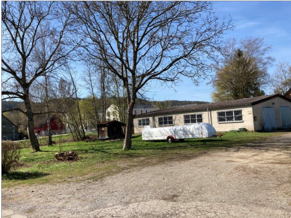
Abb. 13: Vereinsgelände der Flugsportgruppe im südwestlichen Teil des Plangebiets (Foto: HPC AG, 11.04.2022)
