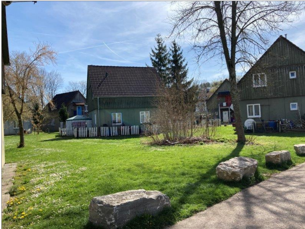
Abb. 15: Holzhaussiedlung im südwestlichen Teil des Plangebiets (Foto: HPC AG, 11.04.2022)
